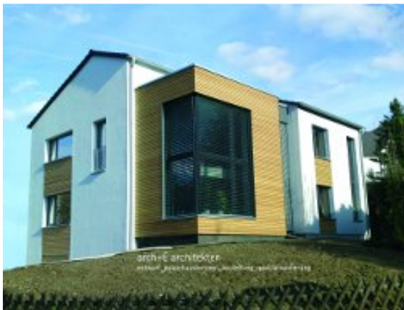
Photo: arch+E ®architekten
