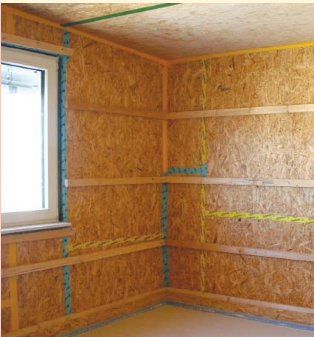
Въздухонепроницаеми връзки между дървесни композитни плоскости
