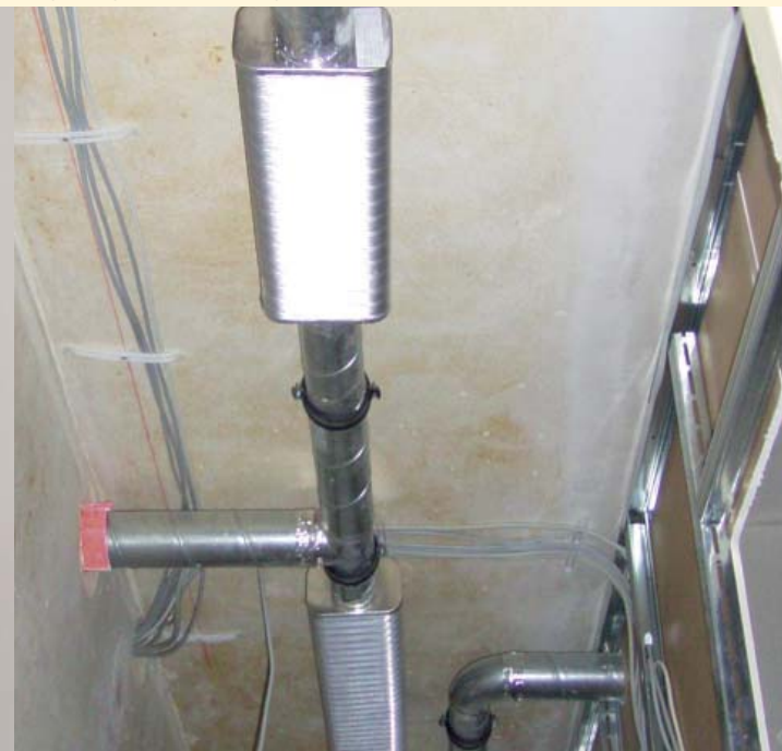
Въздуховодите за свеж въздух със заглушители по време на монтаж
